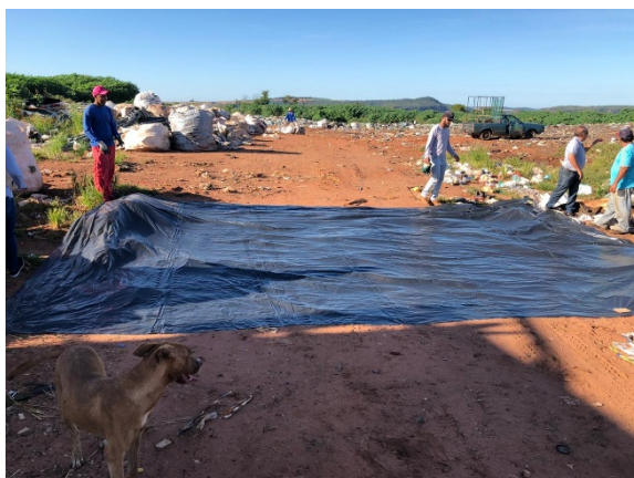
Figura 15 Preparação do terreno com lona. Fonte: MN Consultoria e Soluções Ltda.
